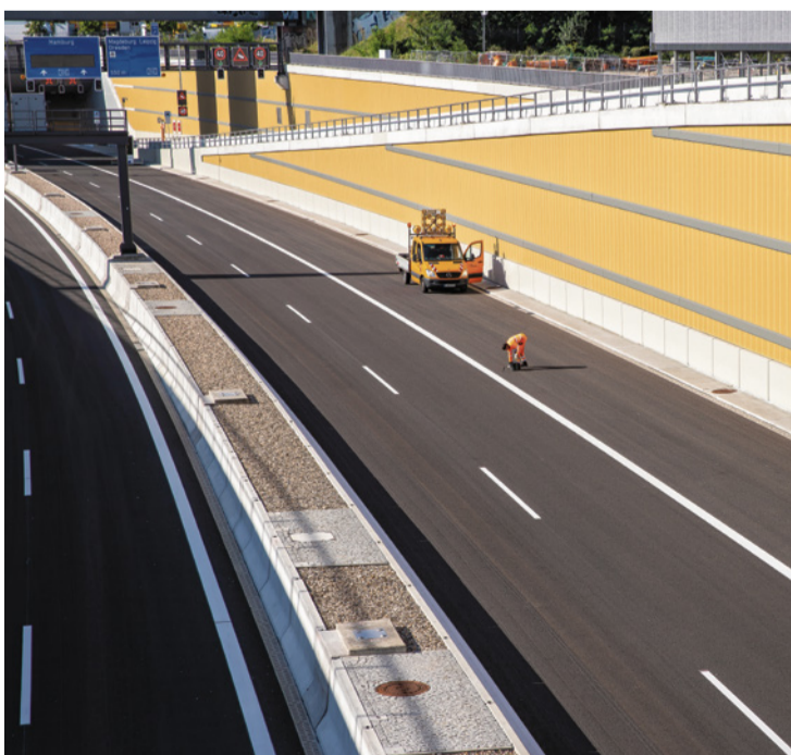
Der neue Teilschnitt der A100 ist endlich fertig
